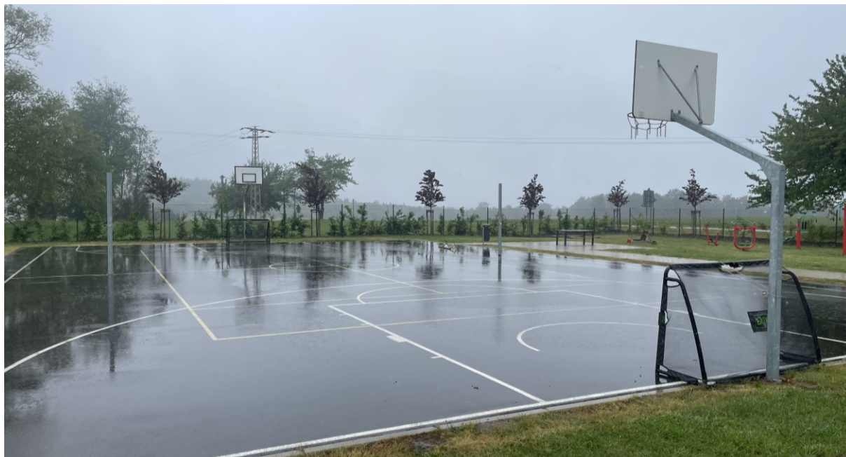
Obr. 34: Hřiště v místní části Skalka Zdroj: ENVIPARTNER, s.r.o. (2024)
