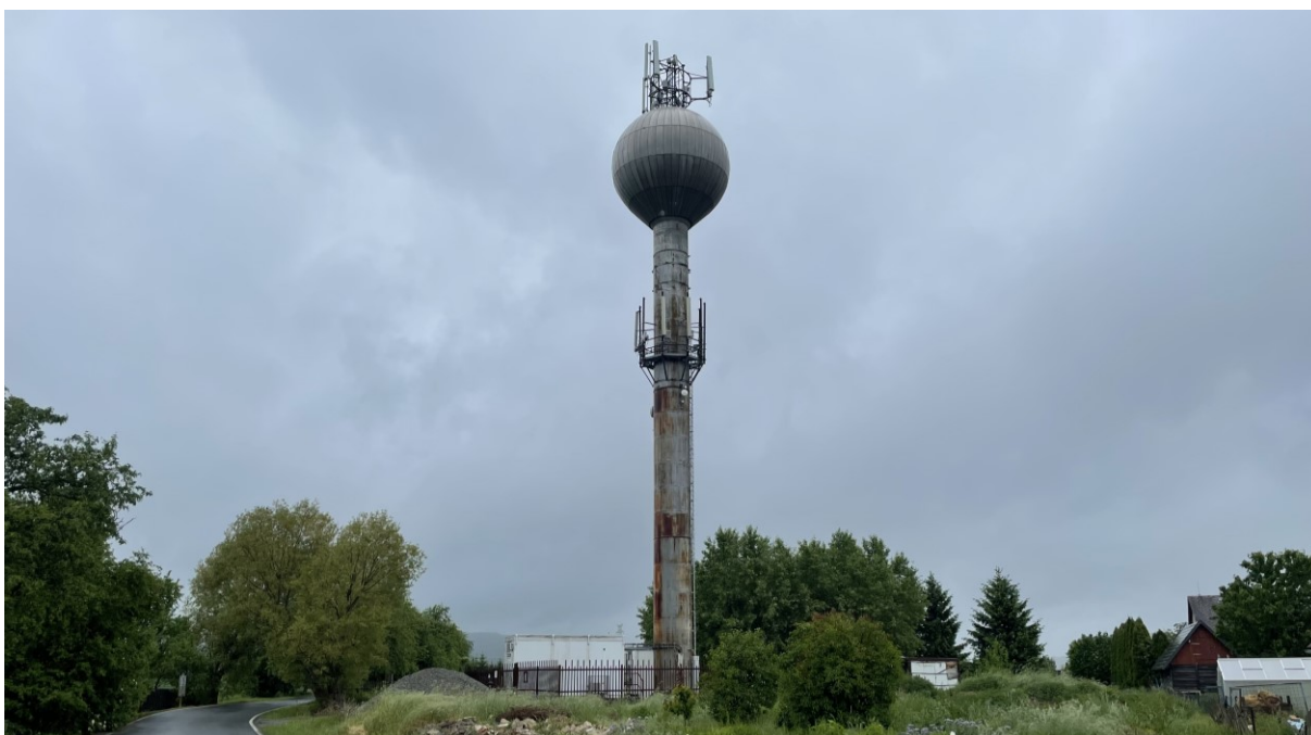
Obr. 23: Věžový vodojem v místní části Blíževedly Zdroj: ENVIPARTNER, s.r.o. (2024)
