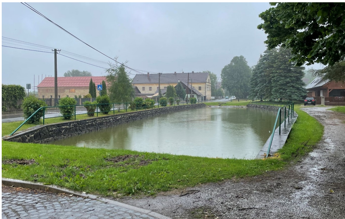
Obr. 4: Hasičská nádrž v místní části Skalka Zdroj: ENVIPARTNER, s.r.o. (2024)
