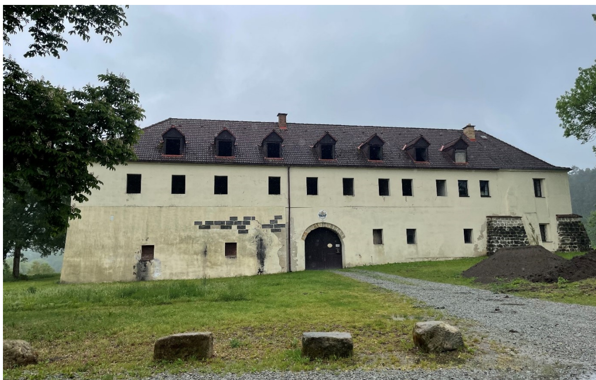
Obr. 22: Tvrz Stranné v místní části Blíževedly Zdroj: ENVIPARTNER, s.r.o. (2024)
